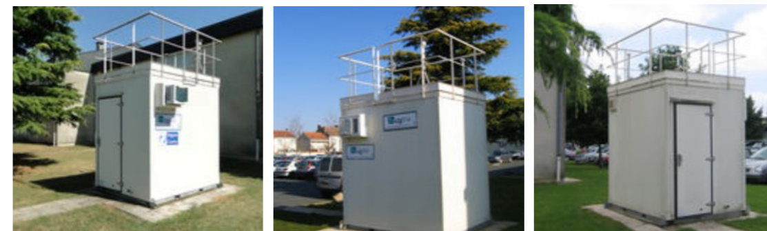
Photographie 1 : Station de mesures de la commune de Châteauroux (source : Lig'Air)
